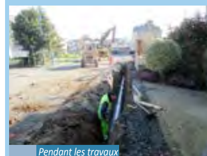
Pendant les travaux
